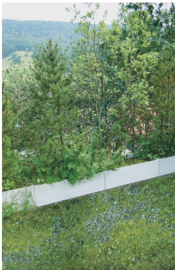
Jardin de toit, remplissage avec du substrat
