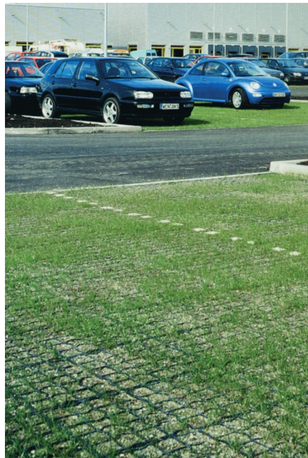
Parking, remplissage avec de l'humus
