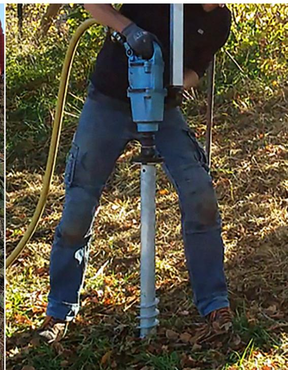
Boulonneuse à choc Makita TW 1000 & OW Ikoki WR25 SEWAZ pour le placement des vis de fondation.
